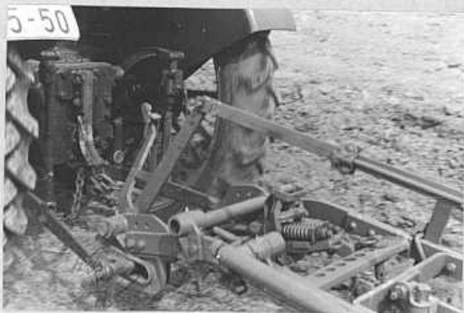
Abb. 2 Führung des Hinterpfluges
