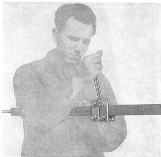
Bild 8 Lösen der Klemmplatte
