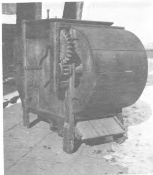
Ca. 150 Jahre alte Getreidereinigungsmaschine, hergestellt von dem Großvater des Gründers.
