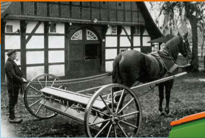
Walzendüngerstreuer AMAZONE HDG Nr. 1 mit 3 m Arbeitsbreite
