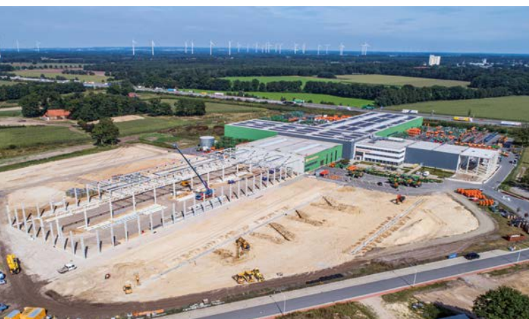
Das Werksgelände in Bramsche
