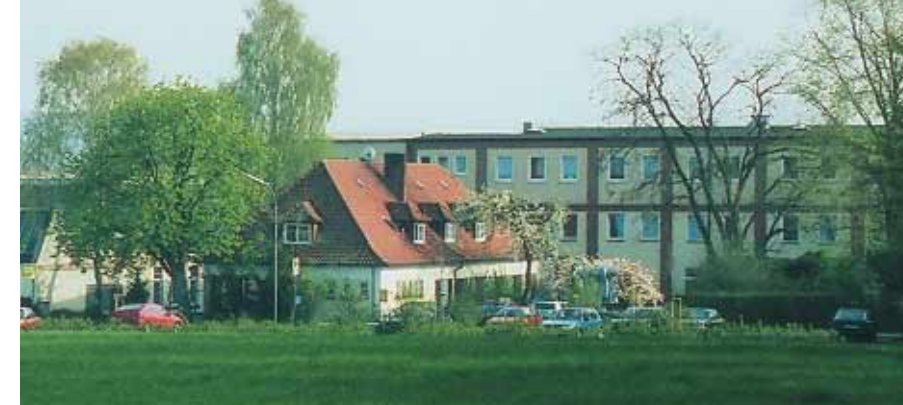
Gästehaus mit Parkplatz
