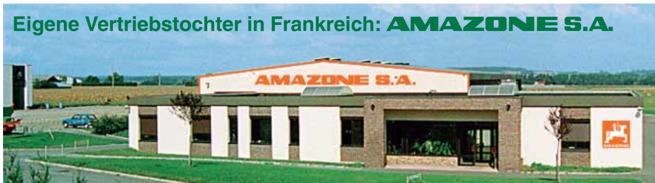
Verwaltungsbüros und Schulungsräume
