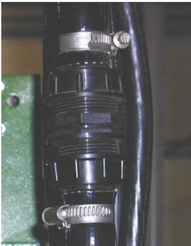
**Abb. 70** Druckleitung heckseitig, 18-36 m - Trennstelle für Prüf-Durchflussmesser
