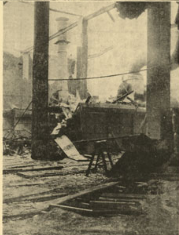
Blick in die zerstörte „Malerei“
