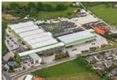
Seit 2007 Produktionswerk in Leeden bei Osnabrück
